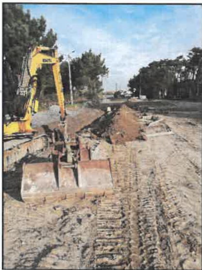
Figura 9 – Infraestruturação de rede pública
