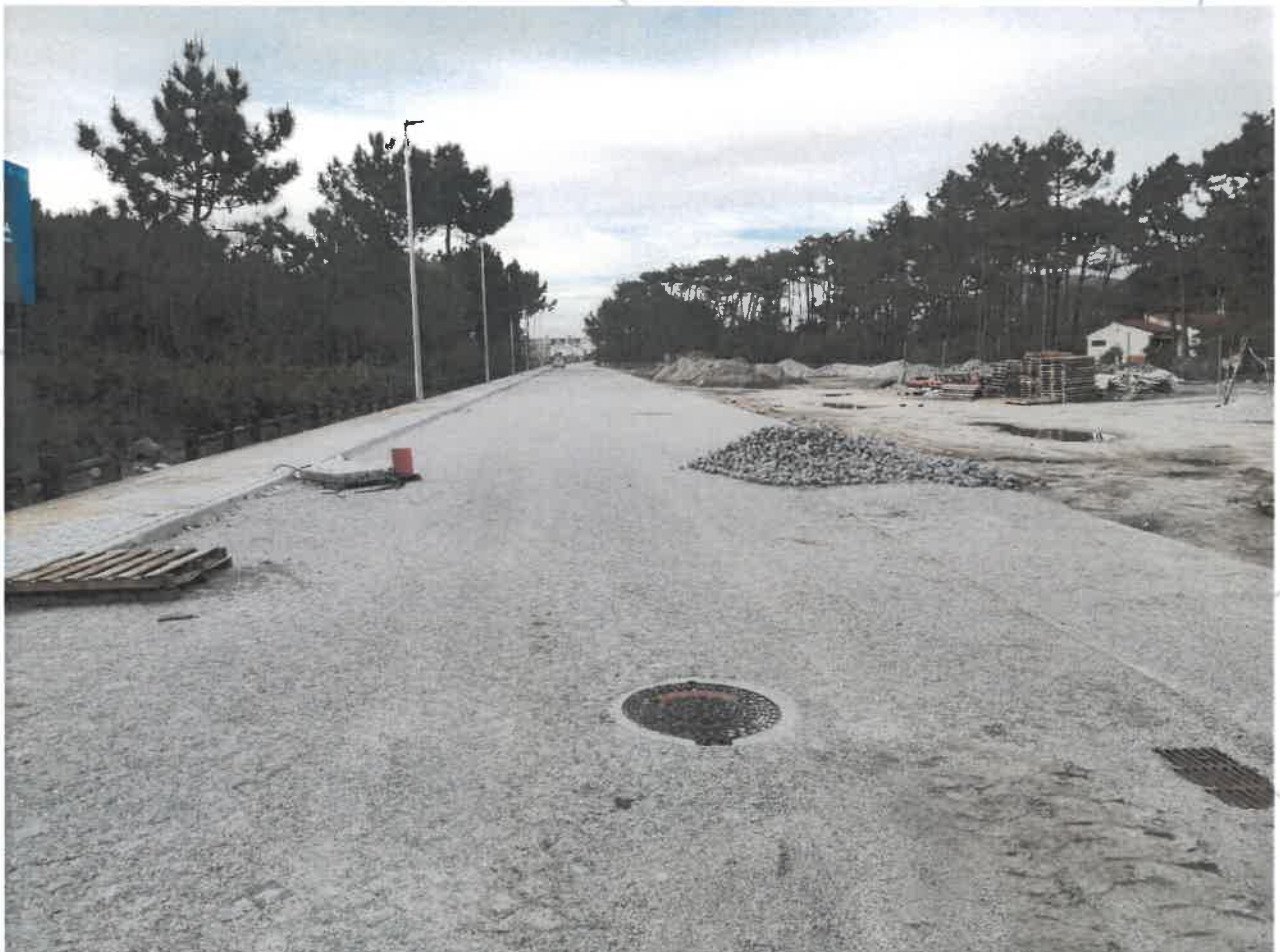
Figura 22 – Execução de empreitada “Requalificação da Rua da Redonda”
