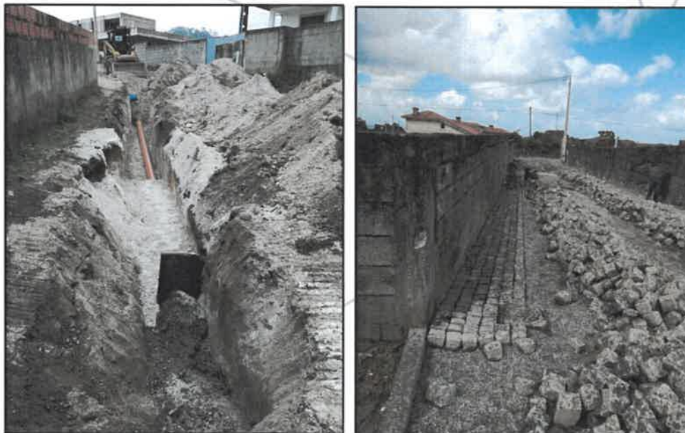
Figura 16 – Infraestruturação rede pública
