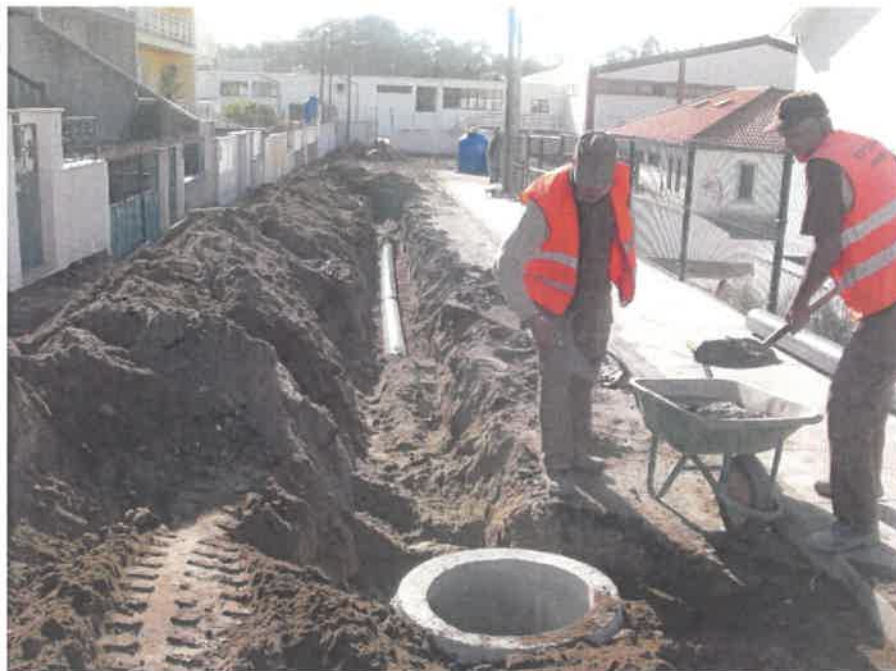
Fotografia 2 – Execução de rede
