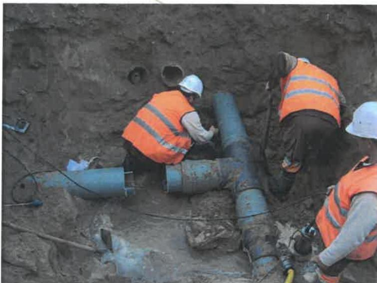
Figura 13 – Substituição de válvulas
