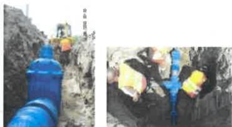
Figura 7 –Trabalho na rede de água
