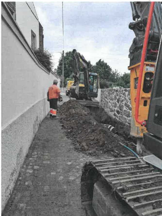
Figura 14 – Ação de trabalhos na rede de saneamento
