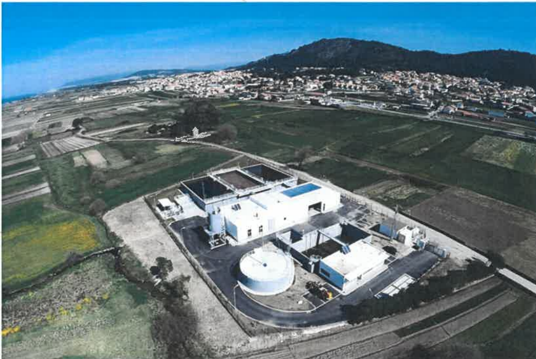
Figura 15 – ETAR de Marinhãs – Investimento Águas do Norte, SA
