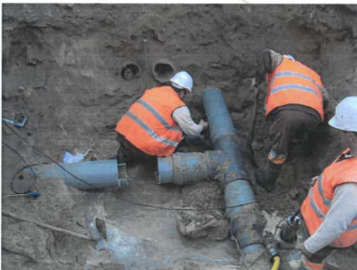
Figura 24 – Execução de empreitada
