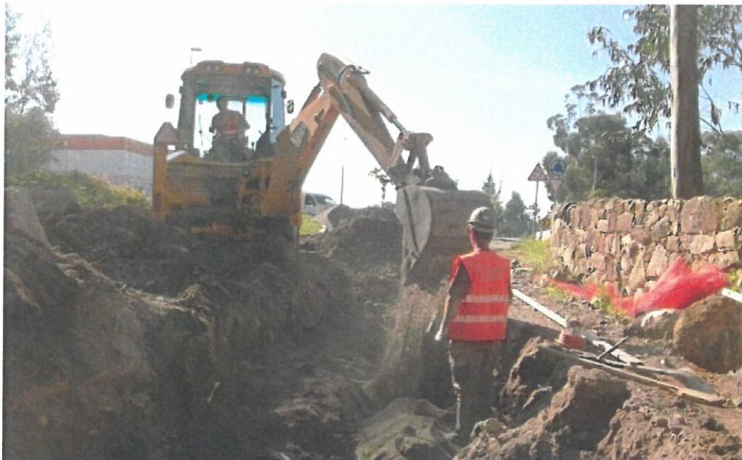
Fotografia 2 – Execução de rede
