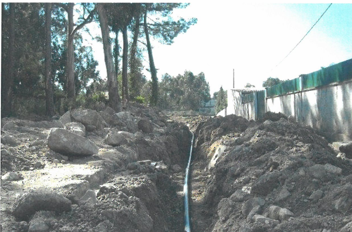
Fotografia 1 - Manutenção e conservação da rede pública água
