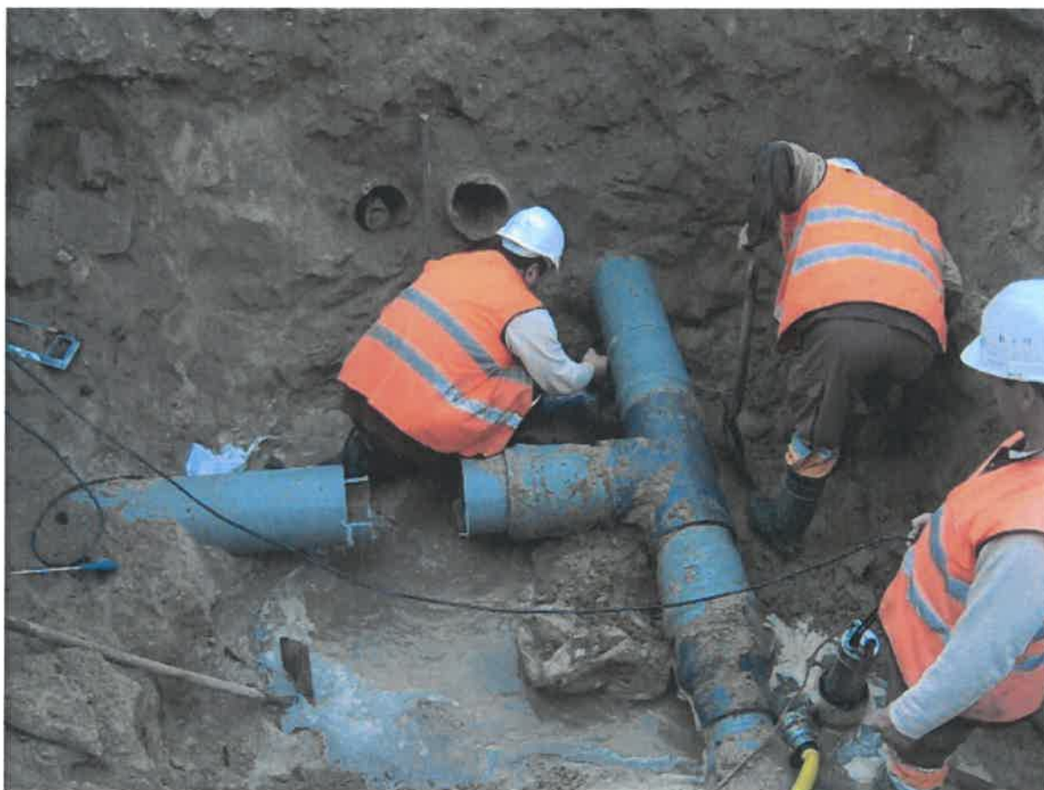
Fotografia 1 - Manutenção e conservação da rede pública água
